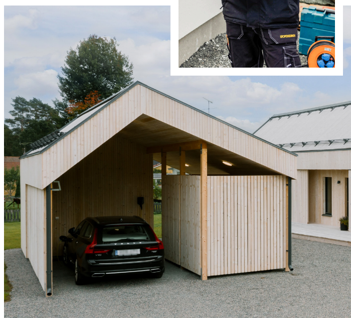
Fiskarhedenvillan valde att sätta carporten på markskruv till deras Villazero, Sveriges första koldioxidneutrala småhus.
